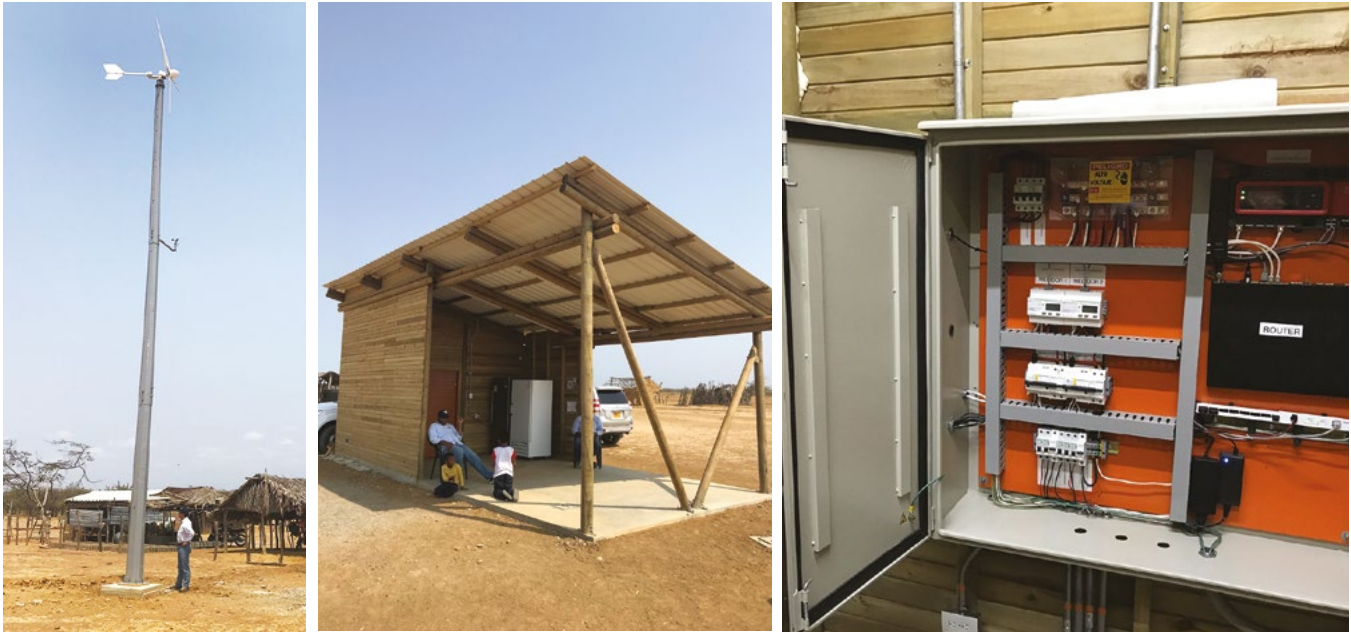
Figura 8. Sistema híbrido (solar fotovoltaico, eólico y baterías).
