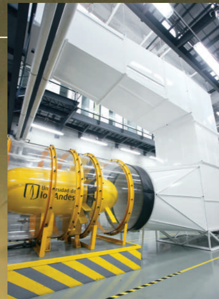
Vista general del túnel y la turbina
